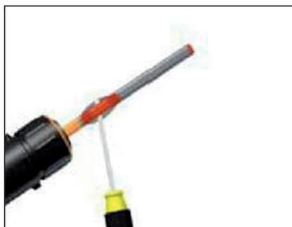
1b. Растяните провода оплетки и сквозь образовавшееся отверстие протяните нагревательный кабель.
